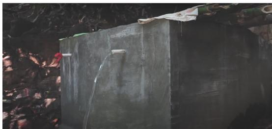
**Gambar 6. Bak penampung untuk air dari mata air**
